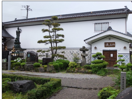
山名氏史料館「山名蔵」。外壁の塗装工事を来年度に考えて居る。
