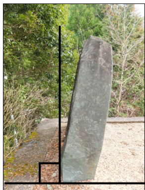
由緒碑の傾き、横から見ると傾きがよく分かる。
