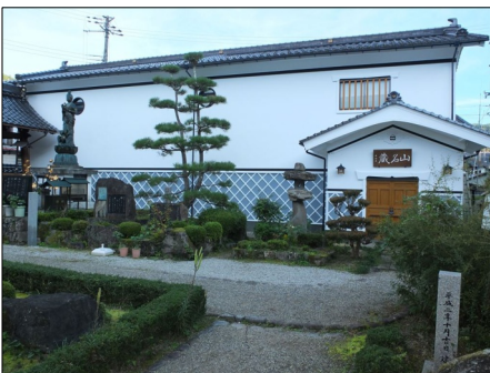
修繕・再塗装が完了した山名蔵。
