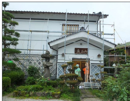
足場を組んで修理中の様子。
